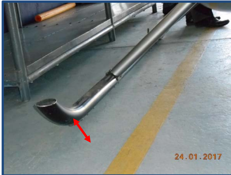
Fotografía No.: 11 Vista del Skid lado derecho separado del suelo.
